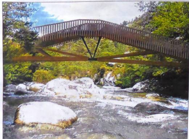
Le projet des Charpentiers de la Corse ne fait appel qu'à du bois de l'île.
