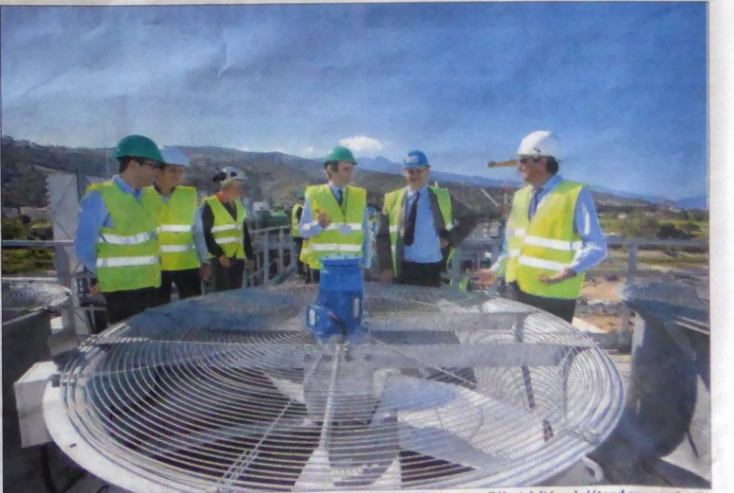
Le préfet de Haute-Corse, Alain Rousseau a visité ce nouvel outil de production d'électricité qui s'étend sur un site de douze hectares, à Lucciana. (Photos Gérard Baldocchi)
